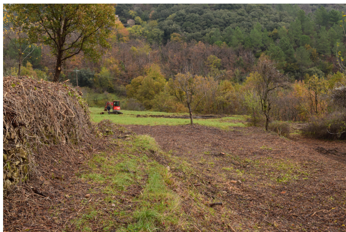
Photo C : Parcelle restaurée après travaux, Brugairolle (30) ©Valérie-Anne Lafont - 2018
