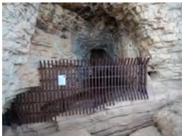
Photo A : Grotte de l'Hortus (34), exemple de protection avec grille (Rodolphe Majurel)
